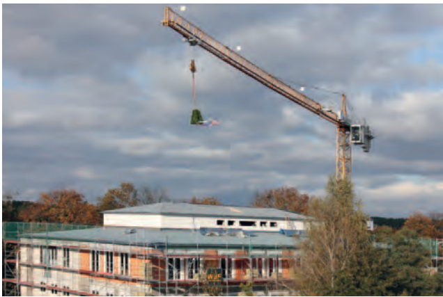
Das MEDIZENT feiert Richtfest Fotos: Krankenhaus Märkisch-Oderland
