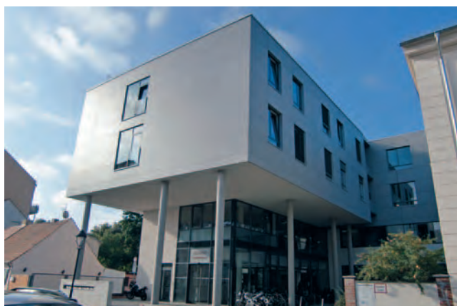
Der Eingangsbereich nach Um- und Neubau Fotos: Oberlin Fachklinik
